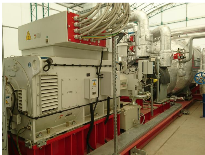
図 1 バイオマス燃焼炉(左)および ORC 熱電併給設備(右)の外観
