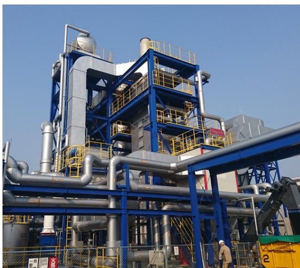
図 1 バイオマス燃焼炉(左)および ORC 熱電併給設備(右)の外観
